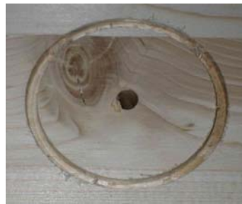
Abbildung 55: Bohrung mit Lochsäge nach Versuchsabbruch
